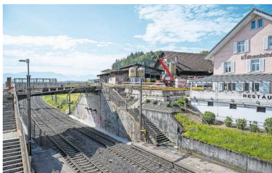
Die alte Überführung beim Bahnhof Mühlau wurde zum Teil abgerissen.
